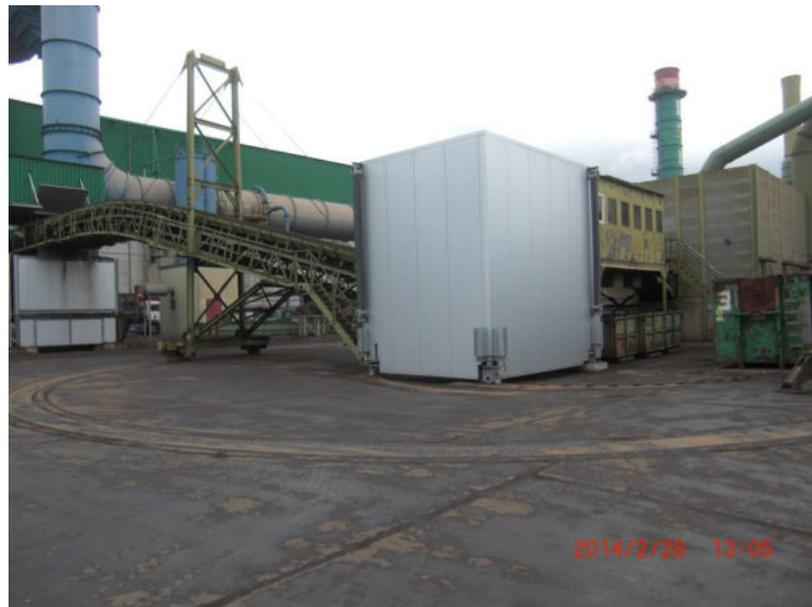
Abbildung 30: Einhausung des Schwenkbandes Nr. 21
