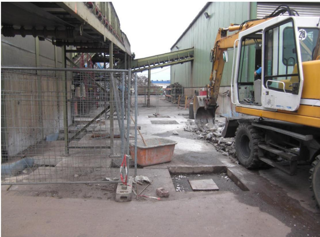
Abbildung 29: Beginn der Bauarbeiten zur Errichtung der Fundamente für Siebanlage und Containerverwiegung an der Shredderanlage (19.08.2013)
