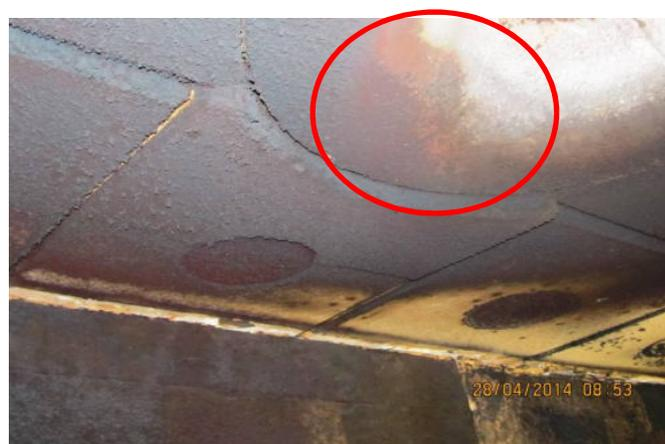
Abbildung 23: Deckensteinbruch aufgrund zu hoher Ausdehnung der Stirnwand
