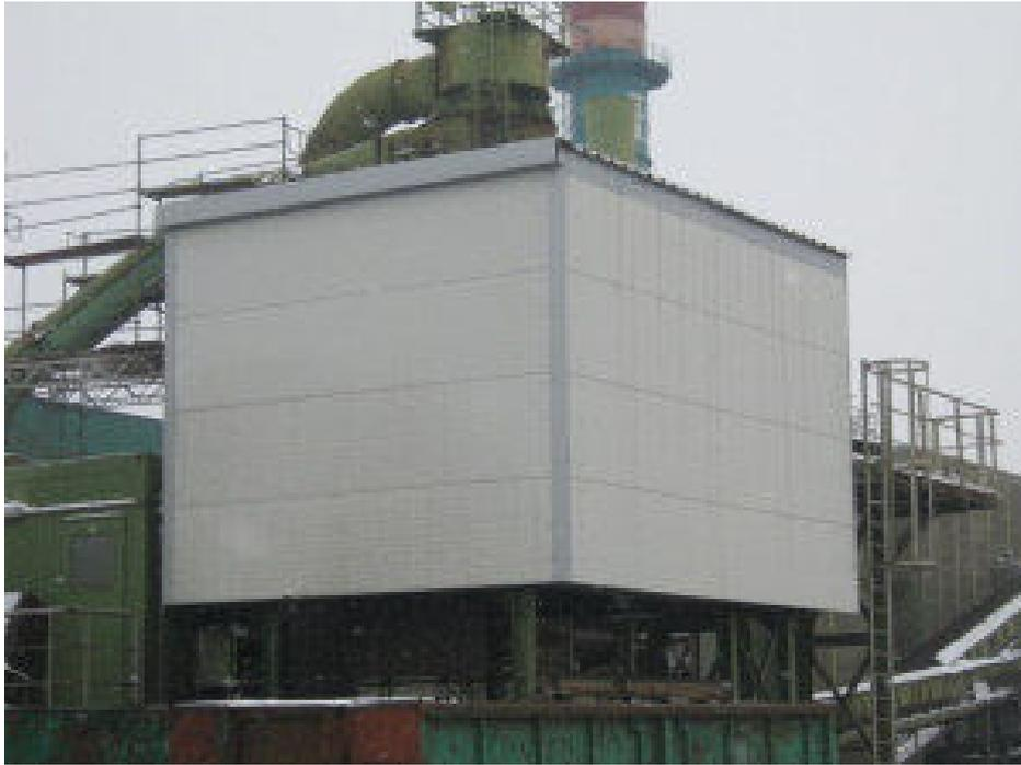
Abbildung 27: Blick auf die Shredderanlage mit neu errichteter Einhausung für die Separierung der Nichteisen-Fraktion aus dem zugeführten Schrott, Aufnahme datum: 14.03.2013
