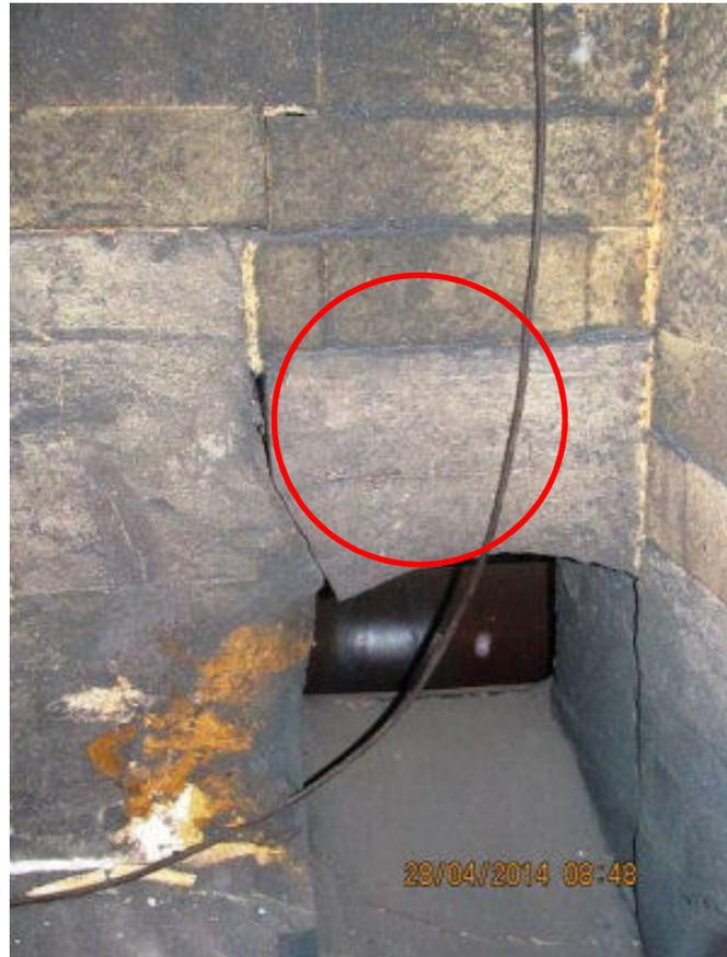
Abbildung 22: Schädigung des Austrageportals
