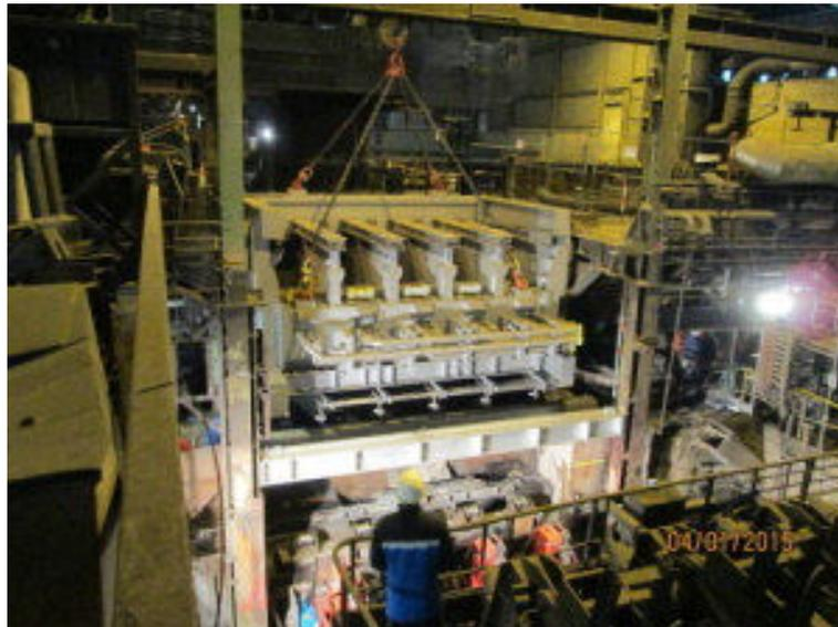
Abbildung 10: Montage des Aufnahmemoduls für die neuen Oszillationsantriebe
