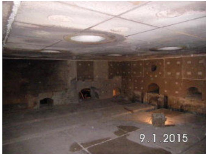
Abbildung 26: Innenraum des Walzwerksofens nach erfolgten Reparaturarbeiten im Bereich der Stirnwand
