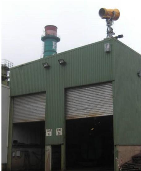
Abbildung 33: Installierte Nebelkanone im Bereich der Shredderanlage
