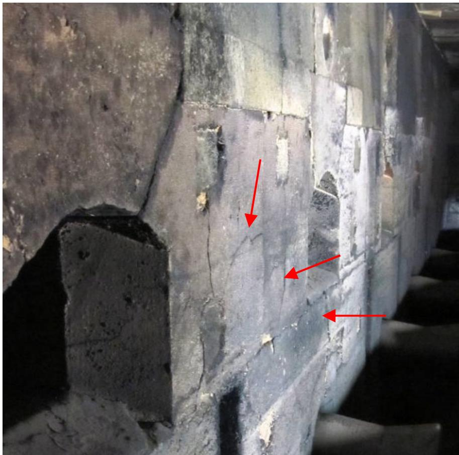
Abbildung 25: Rissbildungen in den gespritzten Bauteilen der Stirnwand
