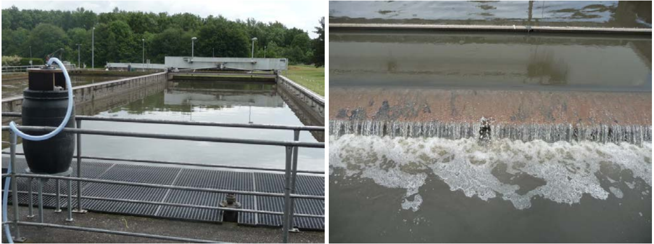
Abbildung 5: Vorklärbecken (KA Grevenbroich)
