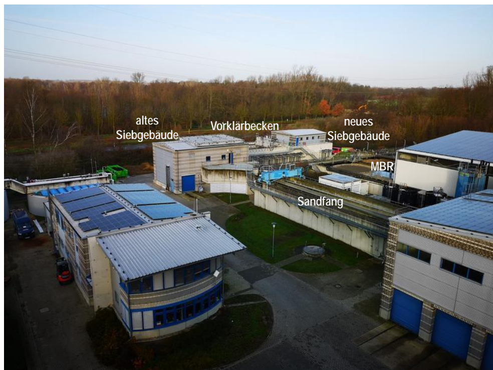
Abbildung 6: Blick auf die neue mechanische Abwasserreinigungsstufe
