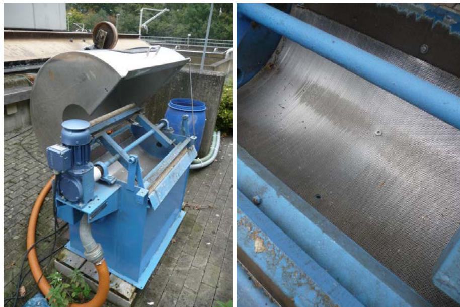
Abbildung 3: Siebaggreat – Muldensieb der Fa. Contec
