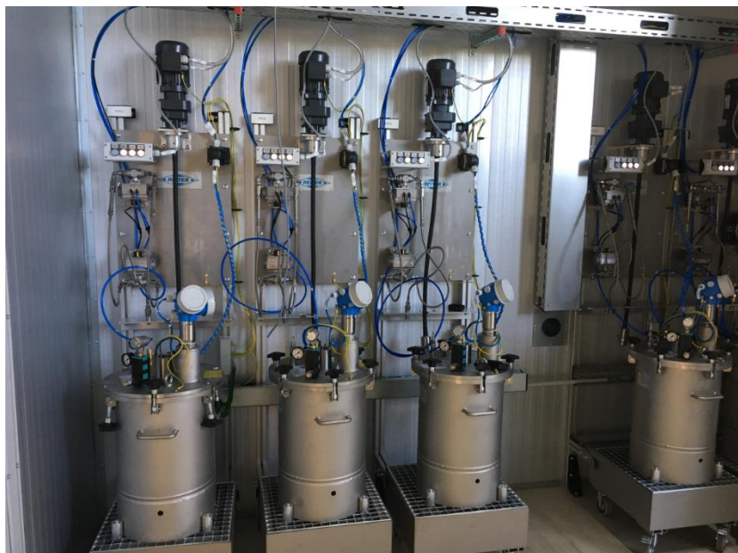
Abbildung 6: Ansicht Lackraum Lackierkabine
