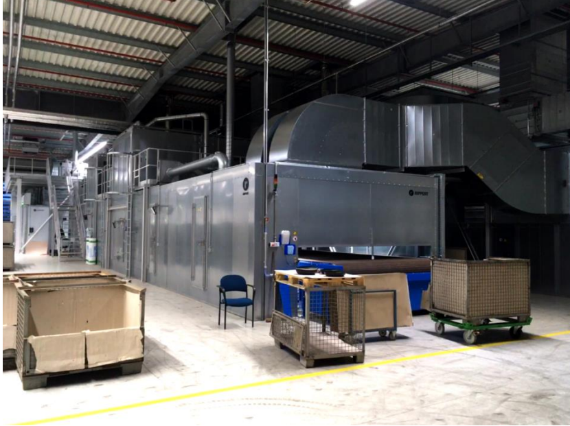
Abbildung 4: Ansicht Lackrockner zum Zeitpunkt der Inbetriebnahme
