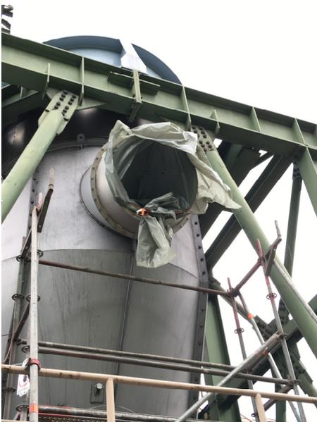
Bild 10: Kaminöffnung (Abgasrückführung des Teilstroms aus der ORC-Anlage)
