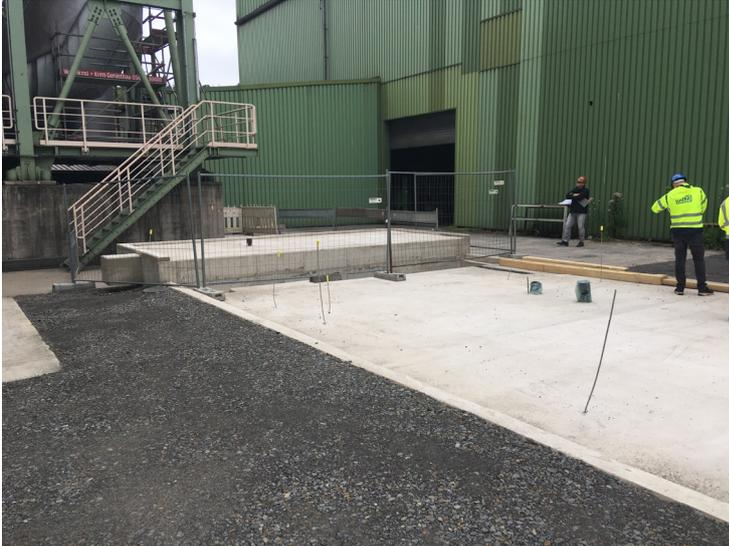
Bild 8: Anlagenfundament, als Auffangwanne mit Gefälle ausgeführt
