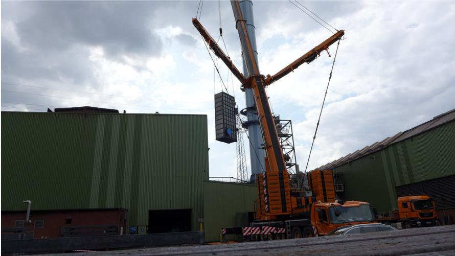
Bild 9: Anlieferung des Verdampferturms
