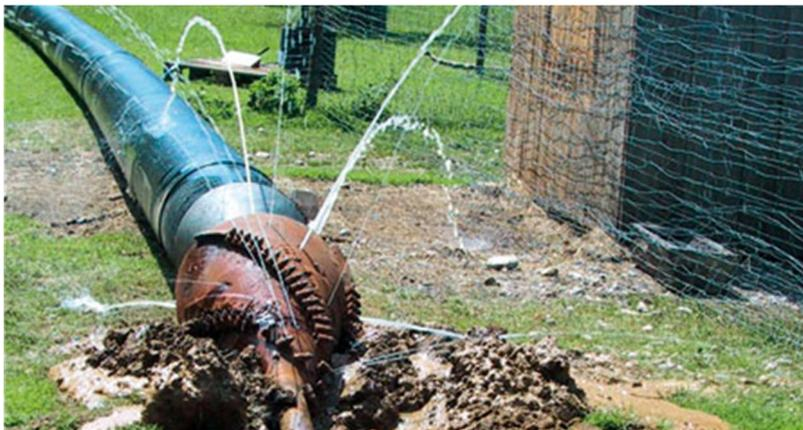
Abbildung 2: Bohrkopf vor dem Einzug einer Kunststoffleitung mit austretender Bohrspülung
