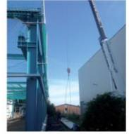
Mit der Baumaßnahme wird die Halle um ca. 400 m² erweitert. Der Anbau, der mit einer Öffnung zu der bestehenden Halle zugänglich wird, dient der Stahlbearbeitung. In der neuen Halle, ausgestattet mit Hallenlaufbänken, werden die Wickelrohrfertigung ebenso wie die Abschlussleistenfertigung ausgelagert. Die fertigen Produkte werden dann in die
