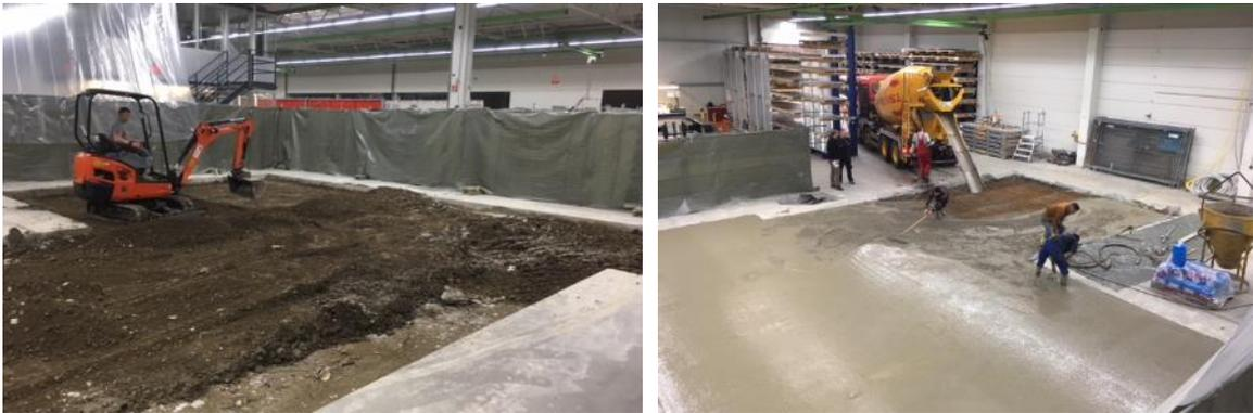
Abbildung 2.22: Fundamentarbeiten für Stanzanlage TruPunch 5000
