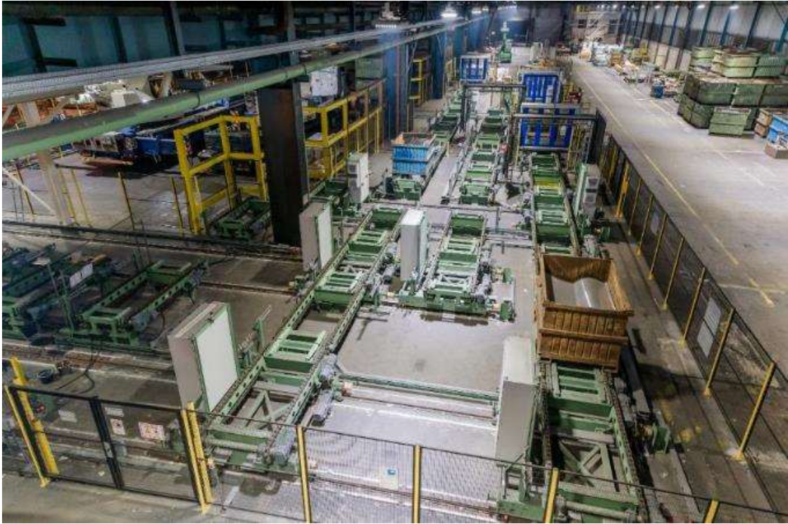
Abbildung 15: Einschleusbereich mit Kettenförderern und Verschiebewagen
