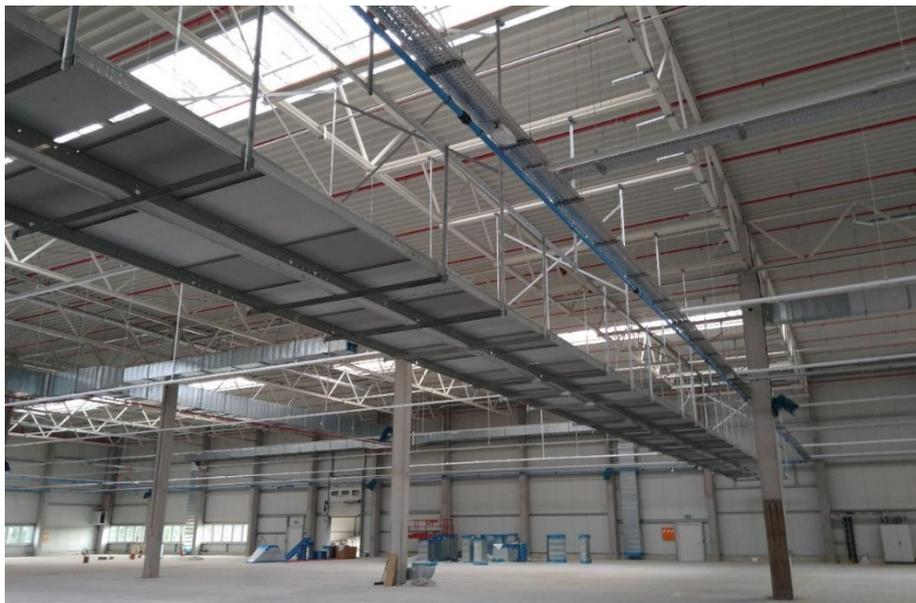
Abbildung 11: 07.06.2021 Grundkonstruktion der langen Abföhrbänder
