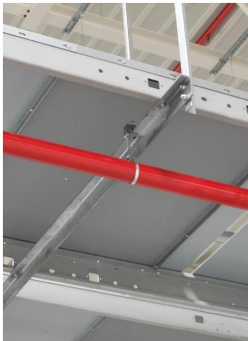
Abbildung 17: Ursprüngliche Befestigung Sprinklerrohre
