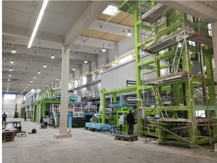
Abbildung 15: Innenansicht der Halle vom Bandeinlauf vom Hallenboden
