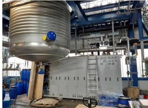
**Abbildung 4: Reaktor C310 (Ansicht unten) mit Temperiergerät (Bauphase)**
