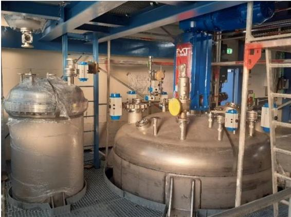
**Abbildung 3: Destillatsammelbehälter und Reaktor C309 (Rückansicht; Bauphase)**
