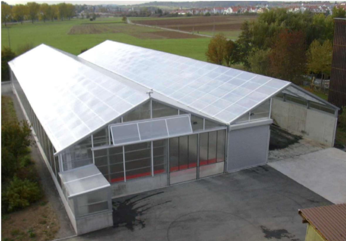
**Abbildung 2:** Solare Klärschlamm-trocknungsanlage Renningen
