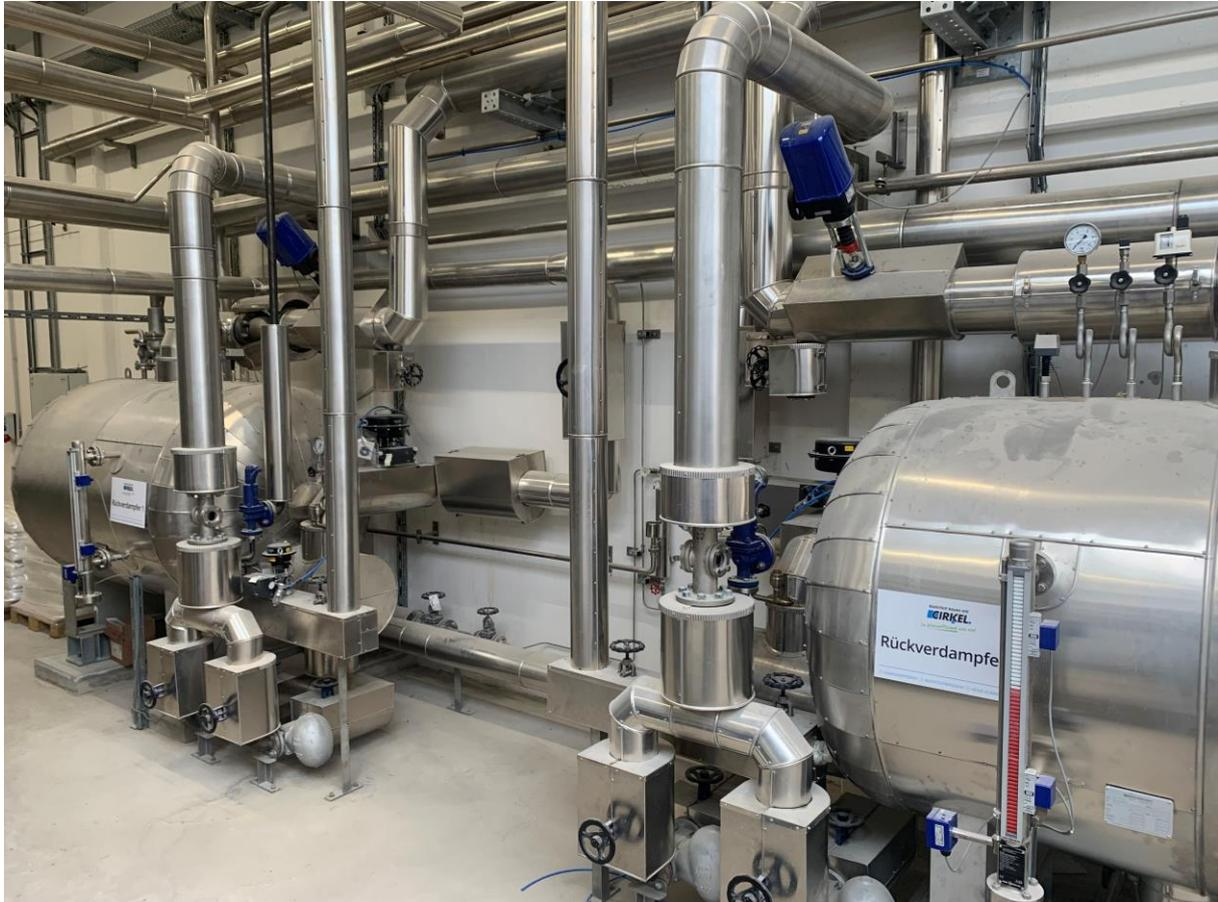
**Abbildung 15: Rückverdampferanlage bestehend aus zwei Rückverdampfern**
