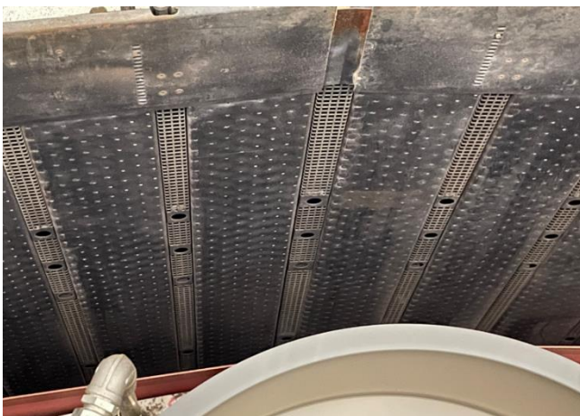
Abbildung 20: Ansicht OptiDry Horizontal Haube auf der Papierseite mit den Öffnungen für Zuluft und Abluft
