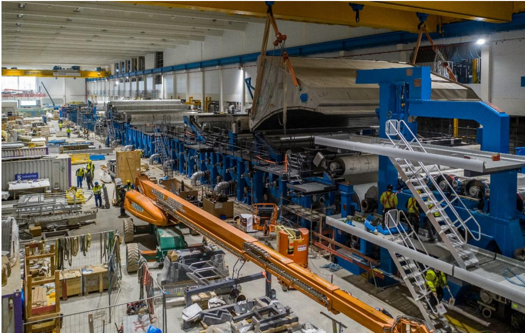
Abbildung 28: Mechanische Montage OptiDry Horizontal Haube und Blick auf die Montage der PM 5neu
