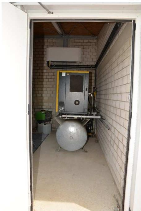
**Abb. 19. Kompressorraum für die Filterzellen**
