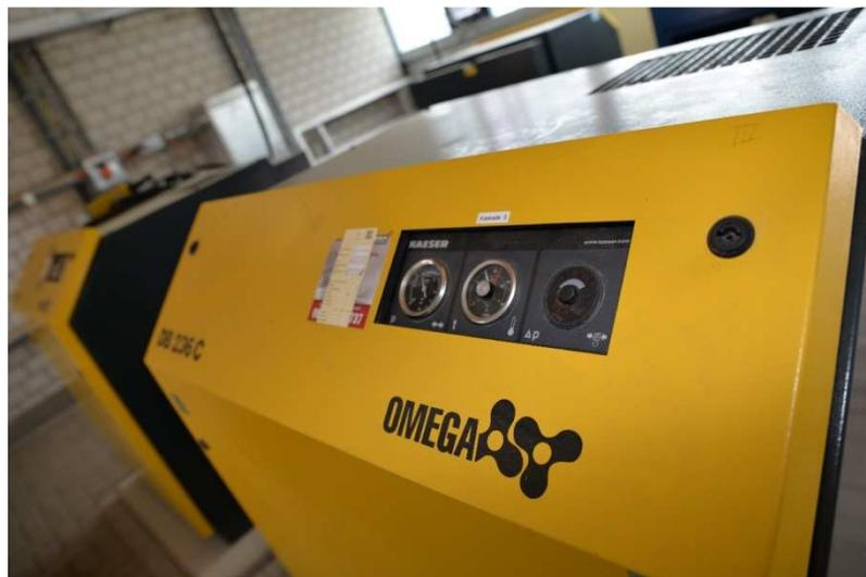
Abb. 14. Gebläsestation nach dem Umbau Detailaufnahme Bedienfeld Kompressor
