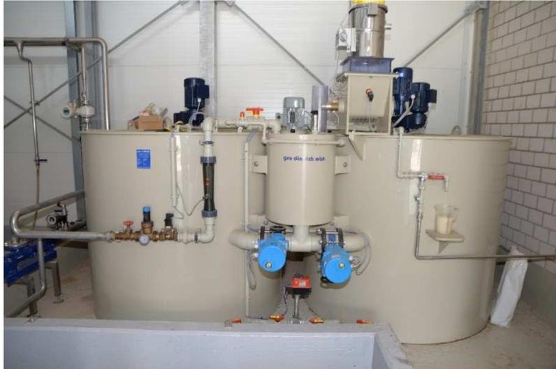
Abb. 35. Polymeranlage für die Zentrifuge
