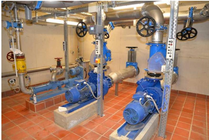
Abb. 16. Rücklaufschlammumpwerk im Maschinenhaus nach dem Umbau
