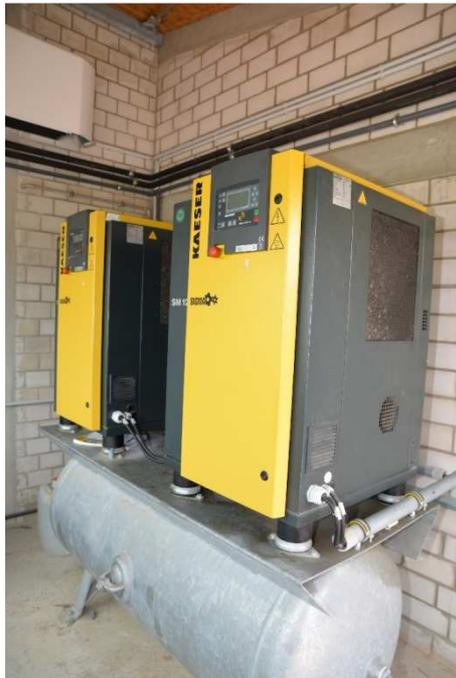
**Abb. 24. Kompressoren für die Filterspülung**
