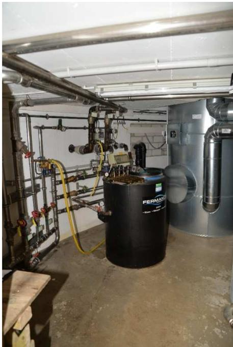
Abb. 31. Fermanox-Anlage zur Brauchwasseraufbereitung
