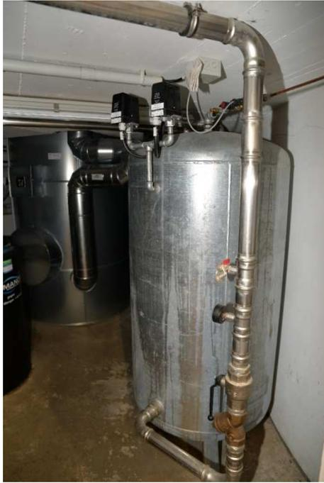
Abb. 32. Druckwasserbehälter
