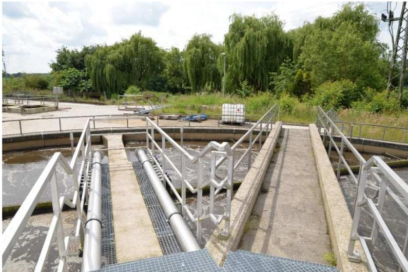
Abb. 10. Kaskade drei, Leitungs- und Bedienungsrücken
