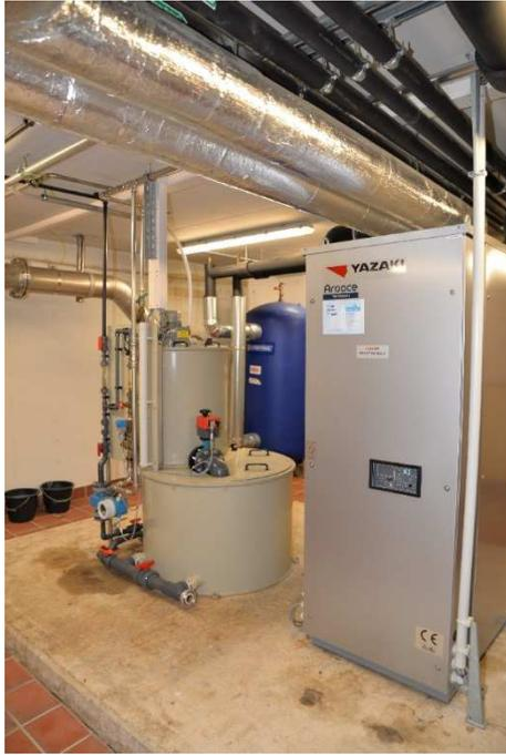
Abb. 28. Station zur Zugabe des Flockungshilfsmittels
