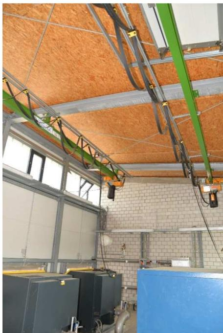
**Abb. 15. Gebläsestation, Kranbahnschiene für den Kompressoentransport**
