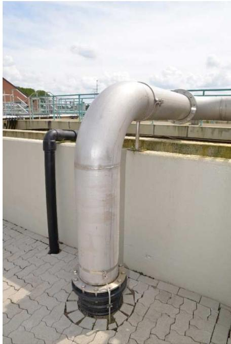
**Abb. 6. Kaskade 2, Rücklaufschlammleitung zur Kaskade eins**
