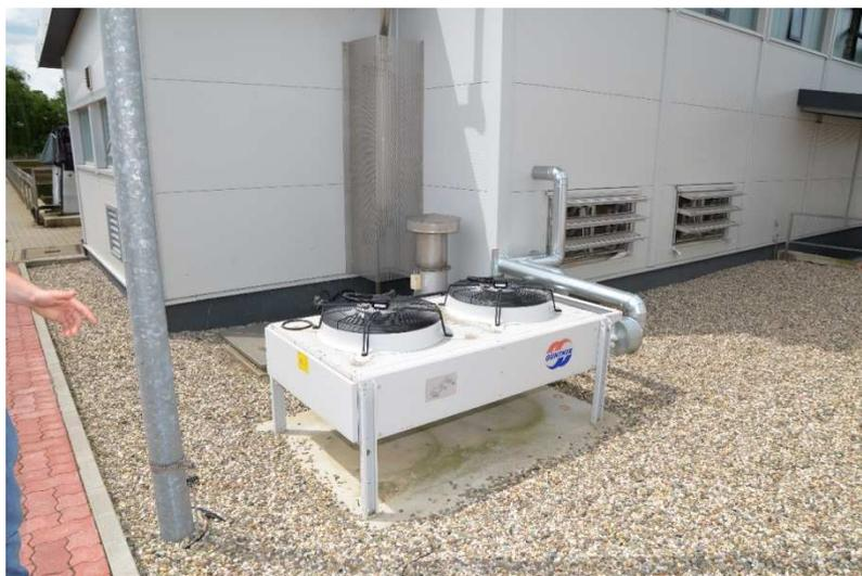
Abb. 34. Notkühlanlage für das BHKW
