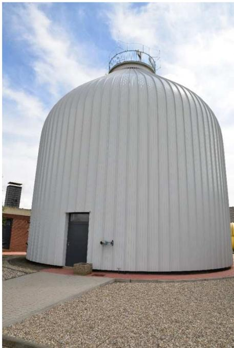
Abb. 29. Faulbehälter mit neuer Bekleidung
