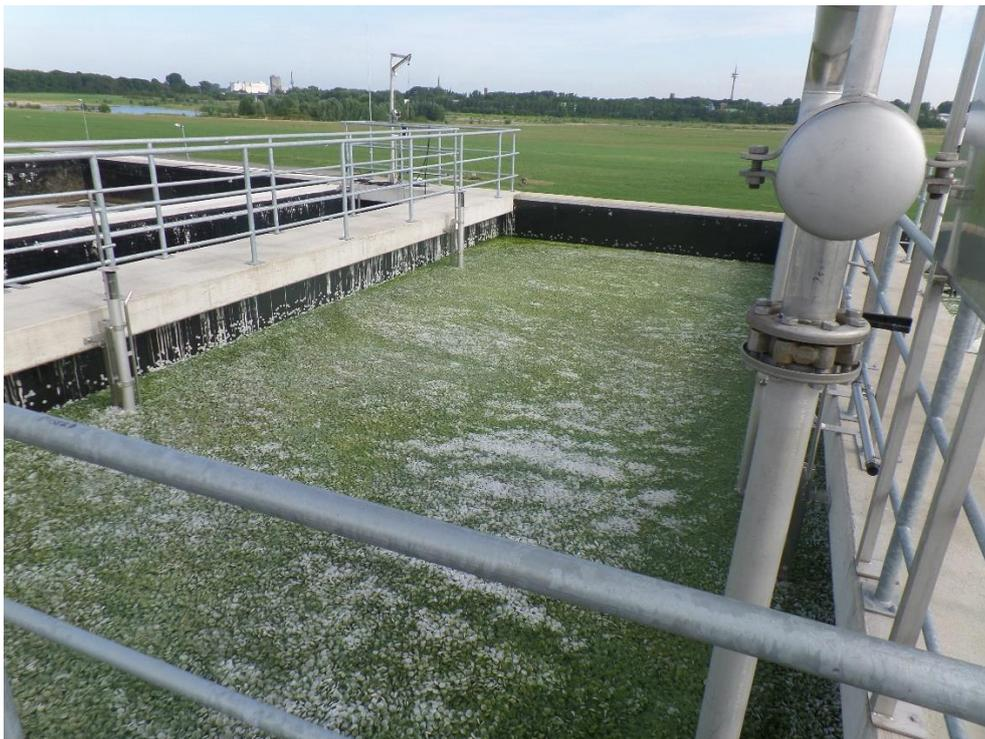
Abbildung 14: Blick in das Nitrifikationsbecken vor Überlauf der Abwässer in die Nachklärung 20.07.2015
