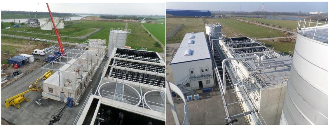
Abbildung 12: Blick auf die 6 x 250 cbm und 2 x 2500 cbm Abwassertanks; davor Pumpenhaus, links daneben Abluffilter und Kamin; im Hintergrund Laborgebäude mit Zuschlagstoffdosierung, Stand 29.01.2015
