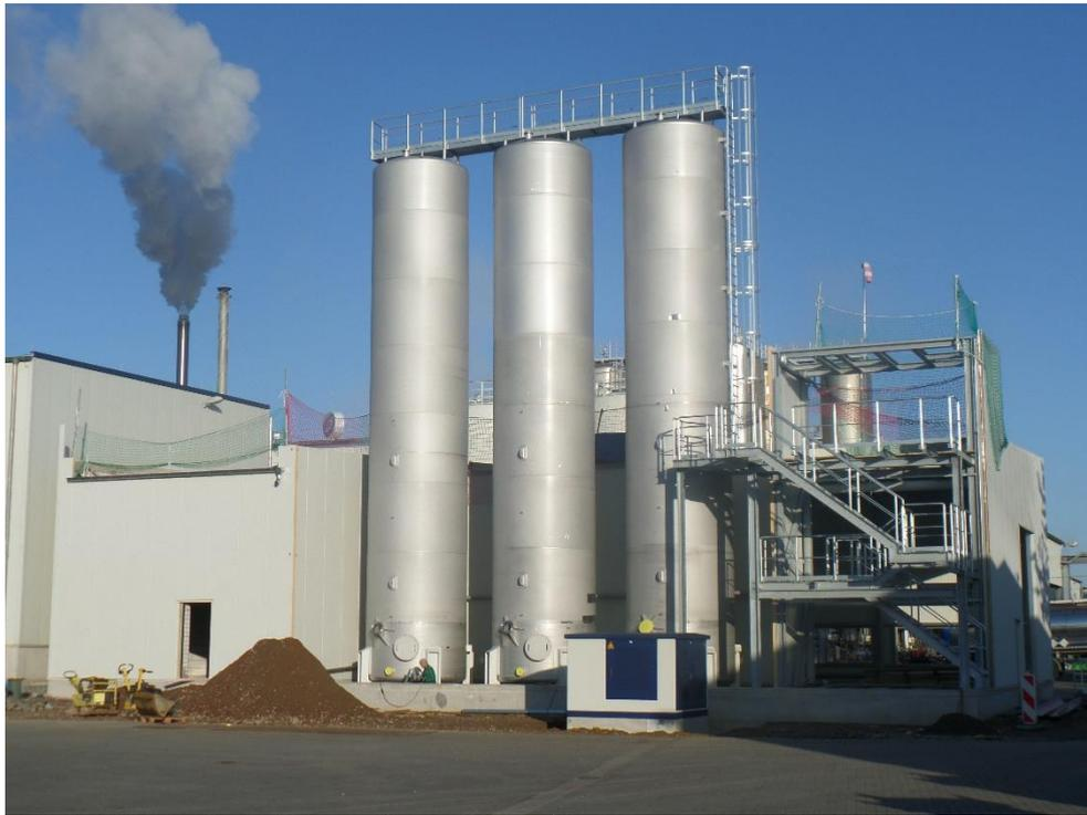
Abbildung 4: Neutralisationsbehälter der Verdampfungsanlage (vom 29.02.2016)
