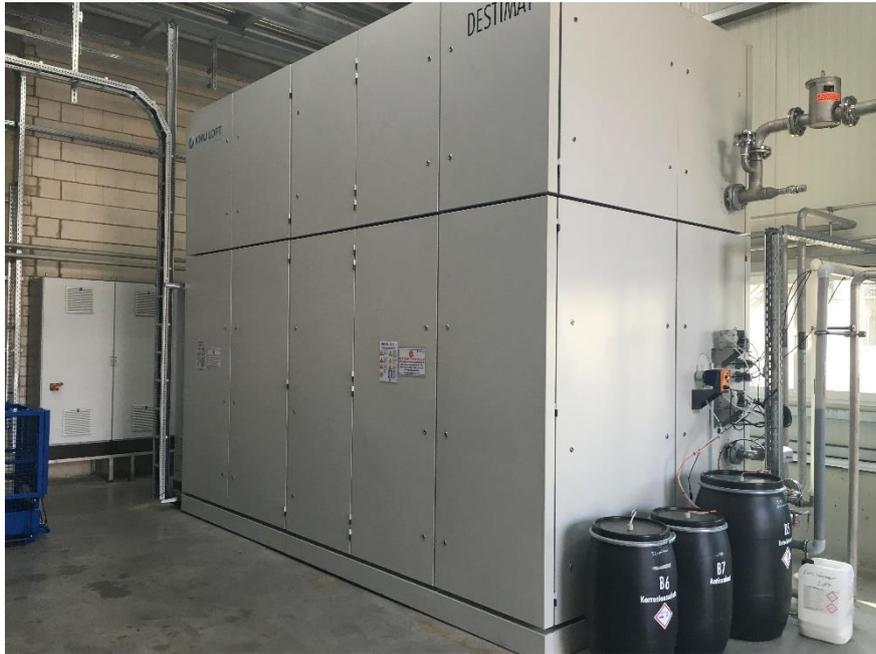
Abbildung 6: Stripkolonne und Dünnschichter (vom 29.02.2016)
