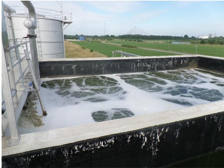
Abbildung 15: Blick auf Übergabestation der Abwässer über die Druckrohrleitung in den Rhein; links: Schlammbehälter; rechts: Nachklärbecken und Sandfilter (im Hintergrund)
