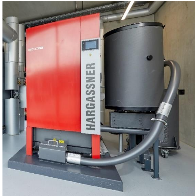
Abbildung 12: Der Pelletkessel in der Energiezentrale der Müller Produktions GmbH
