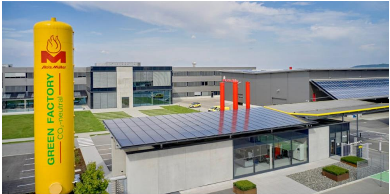
Abbildung 2: Die Green Factory mit ihrer Energiezentrale und dem Pufferspeicher im Vordergrund
