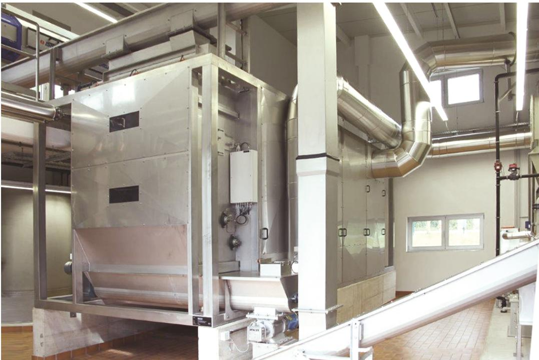
Abbildung 5: Foto des auf der KLA Linz-Unkel installierten Bandrockners EloDry®
