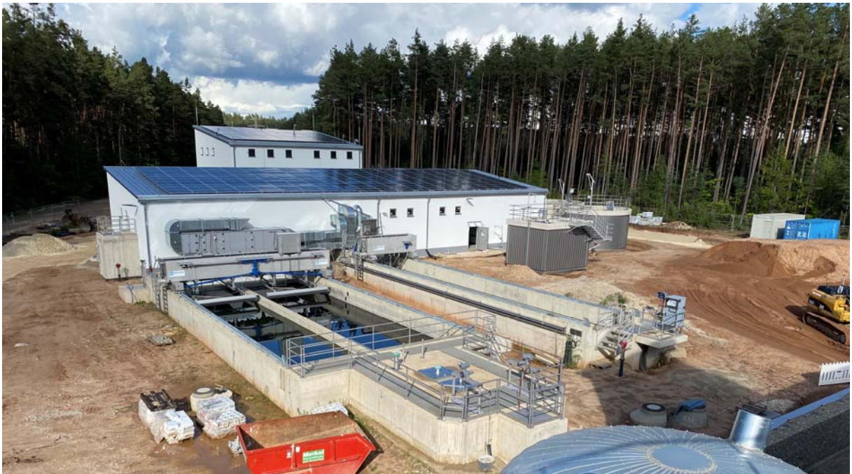
Abbildung 12: Maschinengebäude 1 mit mechanischer Abwasserreinigung, Prozesswasserbehandlung und Schlammstapelbehältern am 20. September 2022
