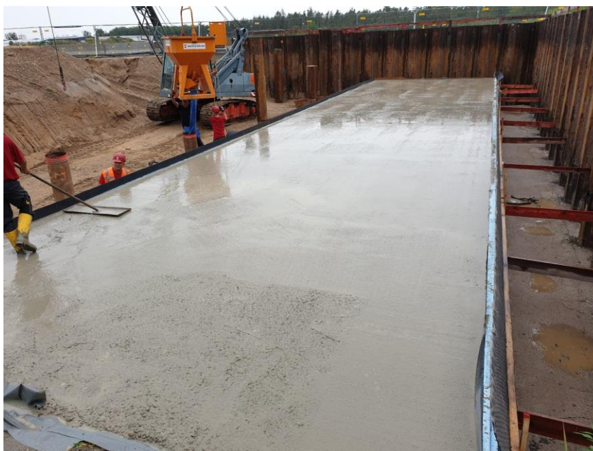
Abbildung 2: Tunnelbauwerk: links Herstellung in offener Bauweise, rechts fertiggestellt mit Rampe Halle Süd
