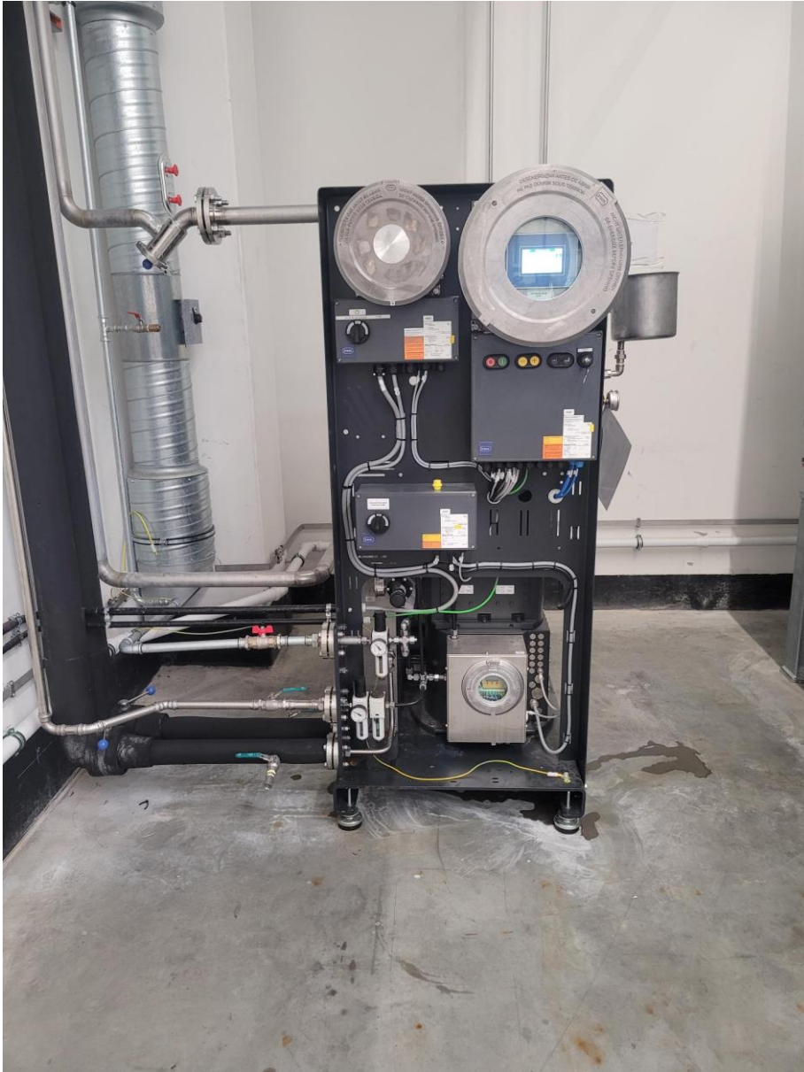
Abbildung 10: Vakuumsystem
