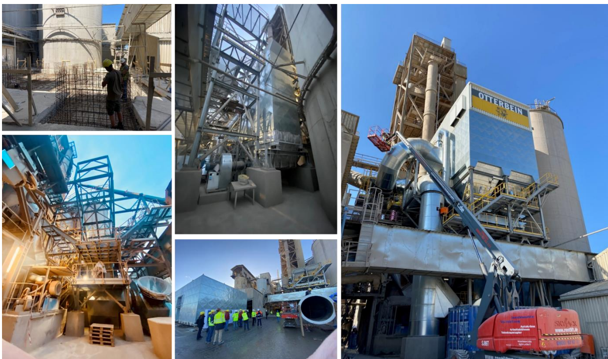
Bild 2-3 Impressionen von der Baustelle
