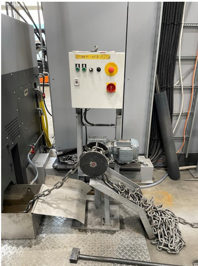
Abbildung 21: Kettentransport am Ende der Anlage Foto vom 17.03.2023
