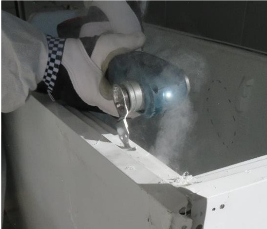
Abbildung 29: Aufschneiden eines Gerätegehäuses zur Perlitabsaugung
