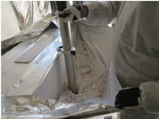
Abbildung 30: Absaugen des Perlits aus dem aufgeschnittenen Folienbeutel
