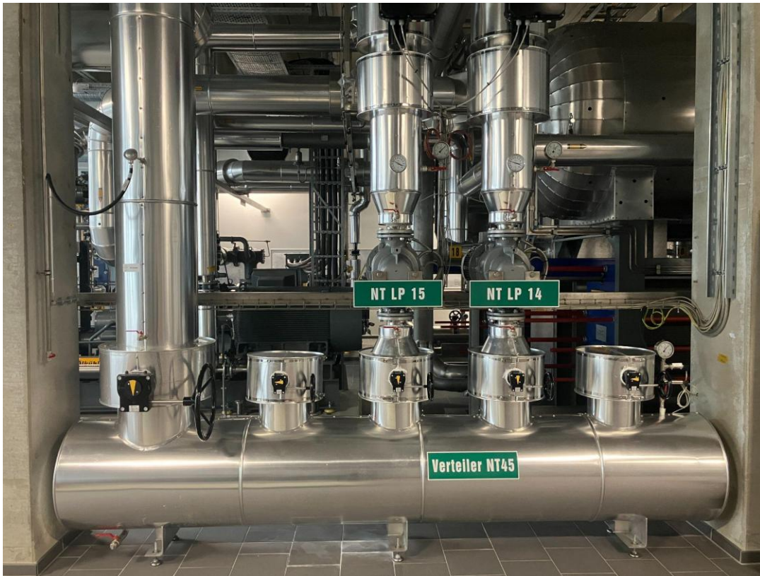
Abbildung 9 Niedertemperatur Sammler und Verteiler (mit Erweiterungsoption)
