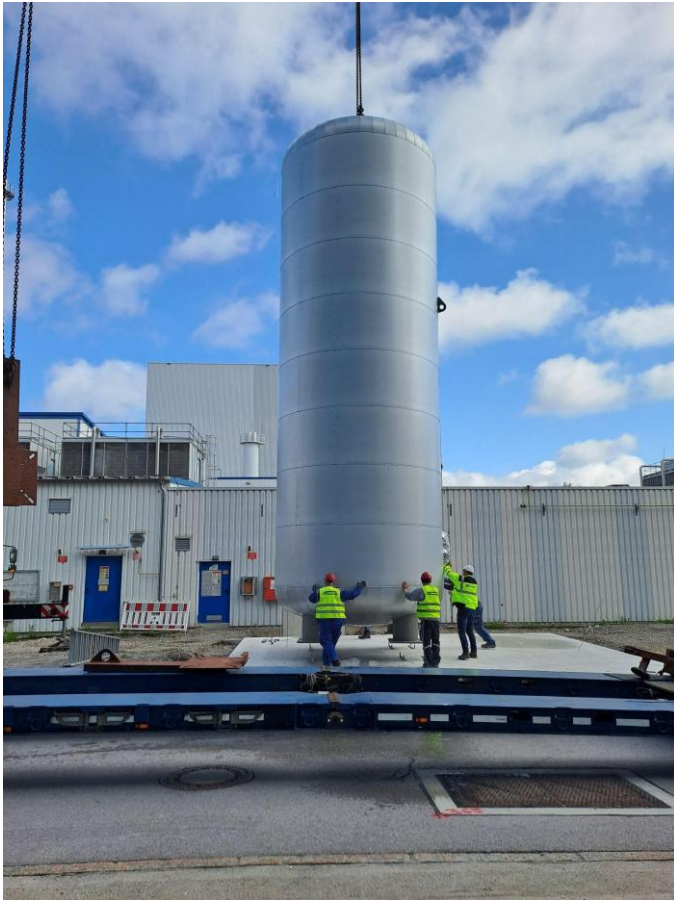
Abbildung 5 Installation des Pufferspeichers
