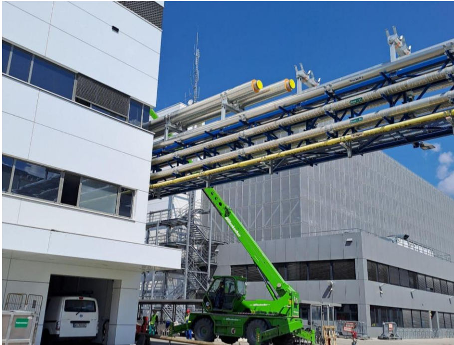
Abbildung 6 Ausbau Rohrleitungsnetz zur Energiezentrale
