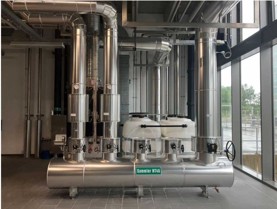
Abbildung 10 Niedertemperatur Sammler und Verteiler (mit Erweiterungsoption)
