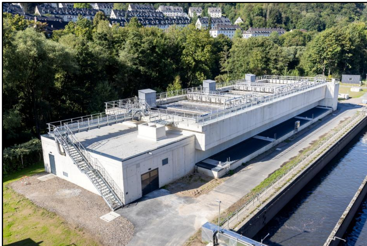
Abbildung 8: Nereda®-Reaktoren inkl. Voreindicker und Maschinenhaus nach der Fertigstellung [Ruhrverband]
