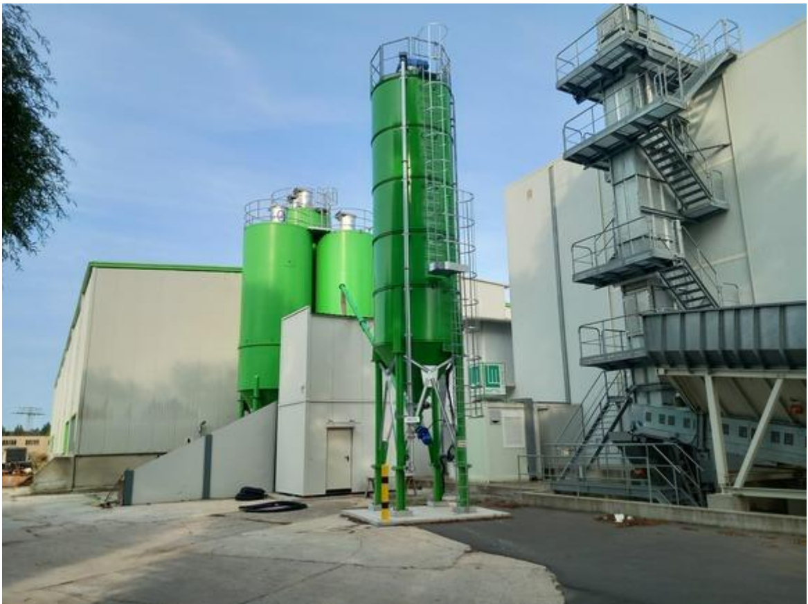
Bild 2: Sonocrete-Anlage in modularer Bauweise als Bypass-System zur M&L-Mischanlage (Quelle: MATTIG & LINDNER)
