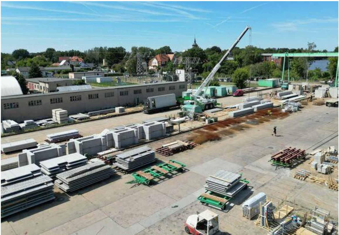
Bild 1: Betonfertigteilwerk MATTIG & LINDNER GmbH (Quelle: MATTIG & LINDNER)
