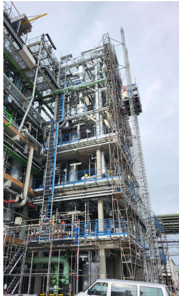
Abbildung 3: HCl-Reinigung nach Montage
