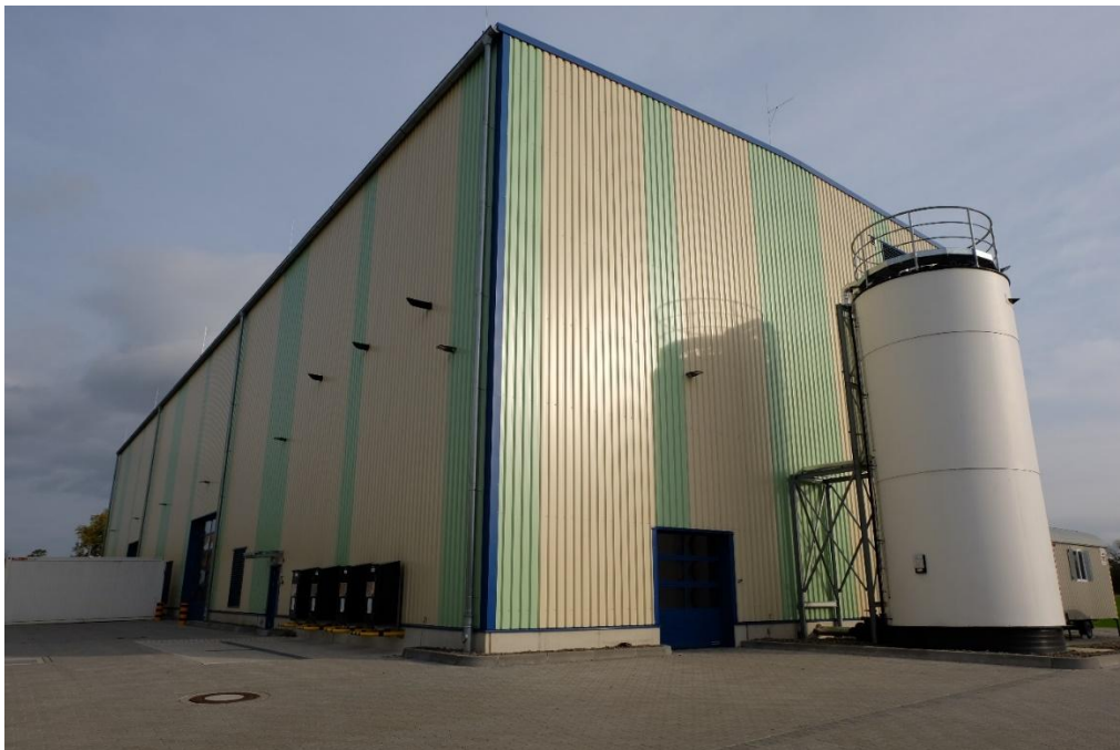
Abbildung 11: Abtankplatz und Zwischenspeicher Flüssigdünger (ASL)
