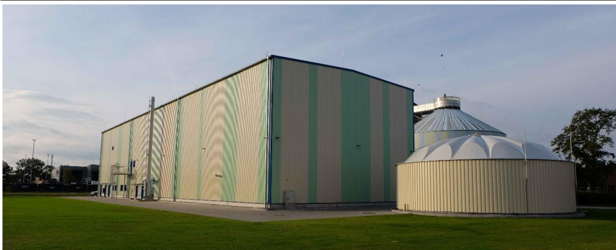
Abbildung 2: Neues Schlammbehandlungsgebäude (Rückseite) mit Prozesswasserspeicher
