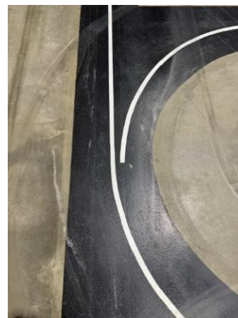
Abb. 11: Führungslinien für das iShuttle am Hallenboden
